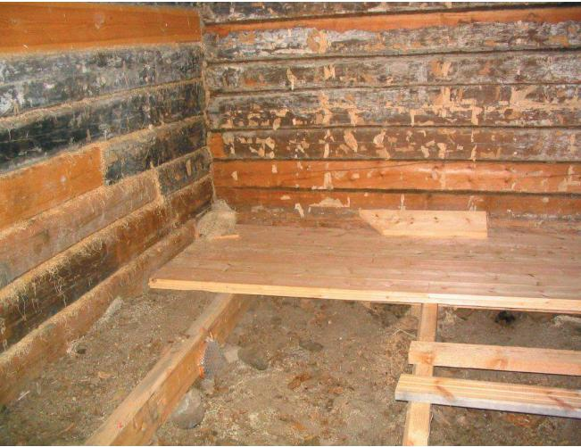
**Kuvat: Multapenkin uusiminen vanhaan rakennukseen. Multahirsien sijaan on käytetty lankkukehikkoa tukemaan multapenkiä. Etualalla näkyy myös uusi tuuletusputki. Esimerkkikohde sijaitsee Pudasjärvellä, Liikasenniemellä. Päärakennuksen vanhimmat osat ovat peräisin 1700-luvulta. Rakennuksen nykyinen omistaja on halunnut toteuttaa korjaustyöt perinteisellä tavalla. Rakennus on tällä hetkellä lomakäytössä.**
