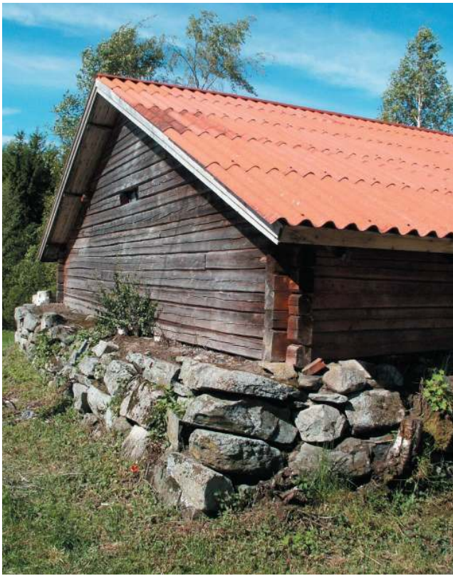
Kuva: Kivinaavetta 1700-luvulta. Kivet ovat luonnonmuotoisia, ja nurkkiin on valittu suurimmat kivet. Lähes puolitoistametriä leveä seinä on ladottu kylmämuurina, ja kiven väleihin on laitettu hiekkaa sekä havunneulastensekaista ainesta. Useissa tapauksissa on vaikea sanoa, miten selvä kivimuurin sisällä oleva täyteväli on. (Alatyypö, Tyypö)
