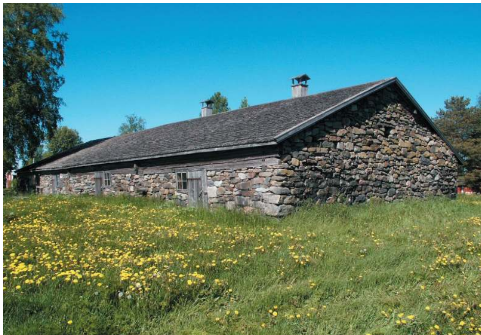
1700-luvun puolivälissä rakennettu Rasmuksen navetta. Kivimuurin hyvä kunto todistaa korkeasta kivirakentamistaidosta. Monet Sääkselän kylän talolliset seurasivat myöhemmin Simon Rasmuksen edistyksellistä esimerkkiä kivenavettojen rakentamisessa.
