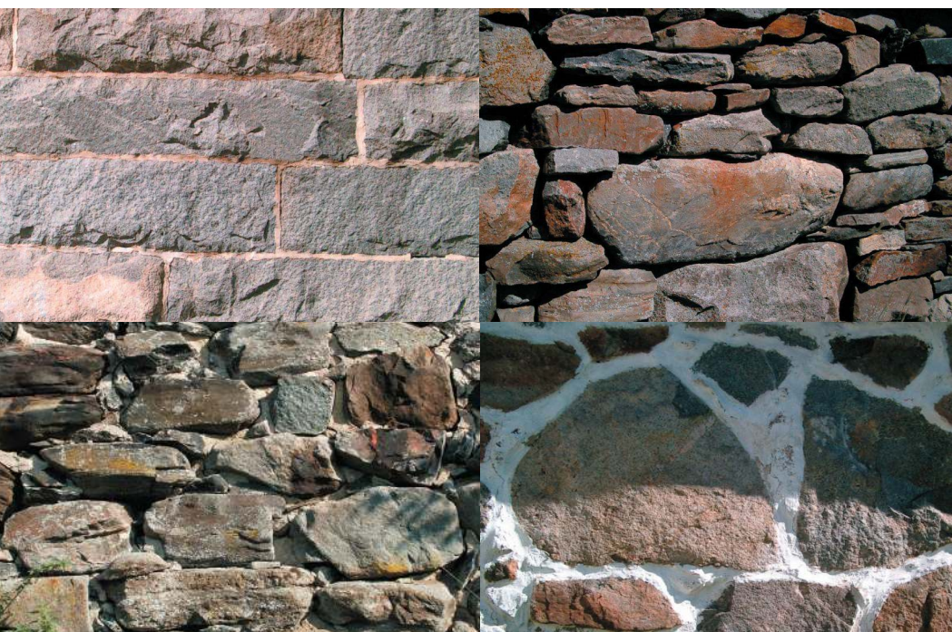
Ylhäällä vasemmalla: Suorakulmaisista harkoista rakennettu, tyypillinen 1900-luvun alkupuolen porakivinavetta. (Pappilan navetta, lisalmi)
