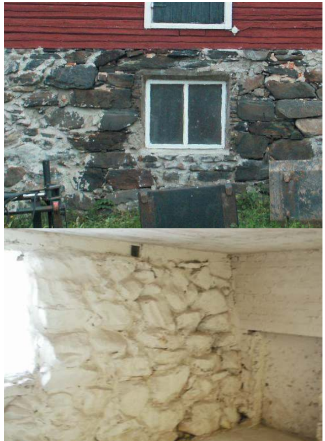
Yllä: Sortunut kivimuri on korjattu sementtipitoisella laastilla vanhasta muurista selkeästi poikkeavalla tavalla. Muuraustyössä tulisi pyrkiä alkuperäiseen kaltaiseen ilmeeseen ja välttää kivien tahrimista laastilla. Navetta on peräisin 1880-luvulta ja yhä käytössä. (Marttila, Kiiminki)
