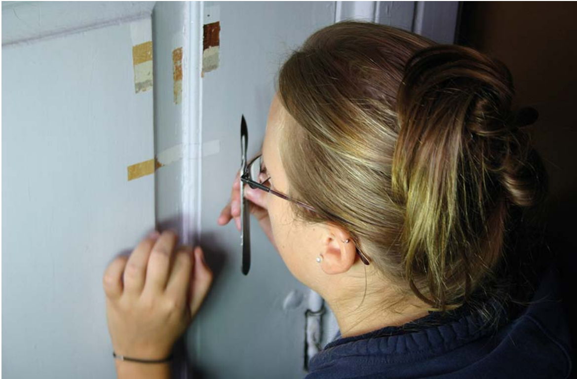
Ovesta löytyneet värikerrokset kertovat eri aikakausien väri-ihanteista. MV/Rho Marja Ivars 2010
